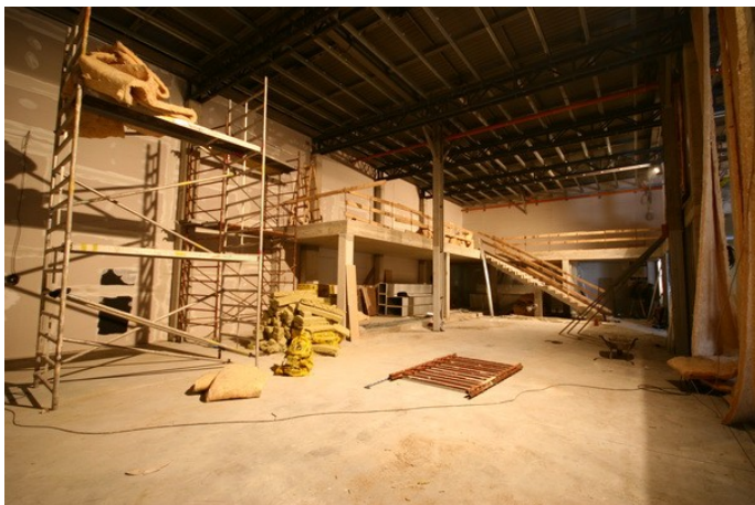
2007. december – hangszigetelés telepítés
