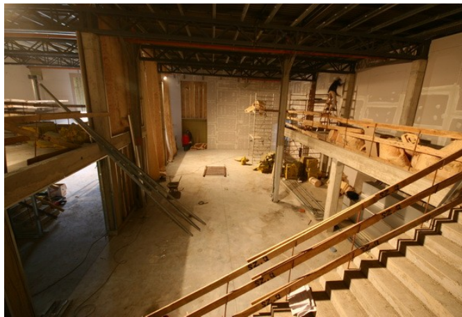
2007. december – hangszigetelés telepítés
